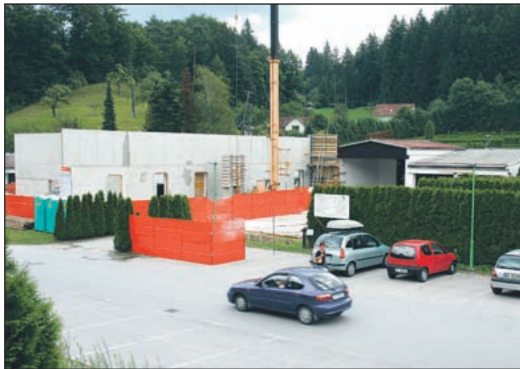
Izgradnja pokritega poslovnega prostora in mrliških vežic je zelo zahtevna projektna naloga, v rednih korakih milijon evrov. (foto: v os)
