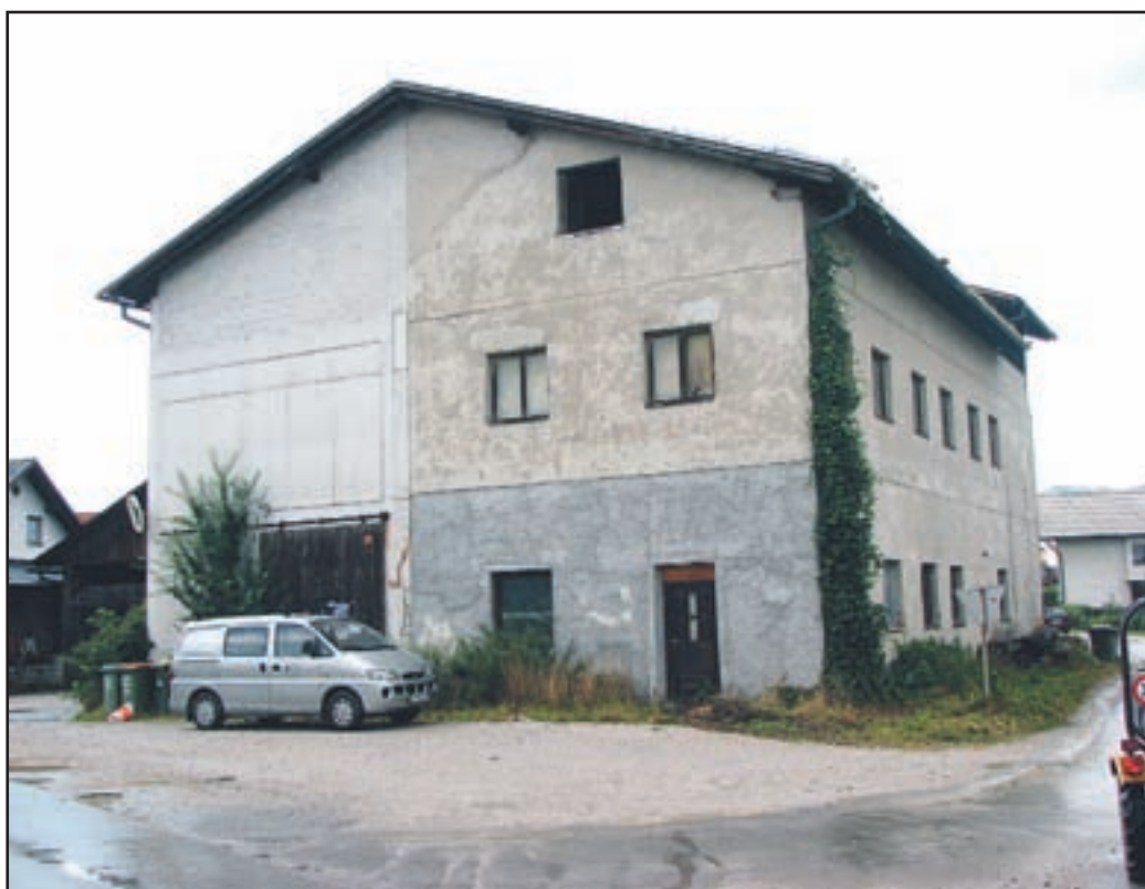
Nam estu, kjer danes ropadas ušilnica, bo stal novp osnovno-skladiščni objekt.
