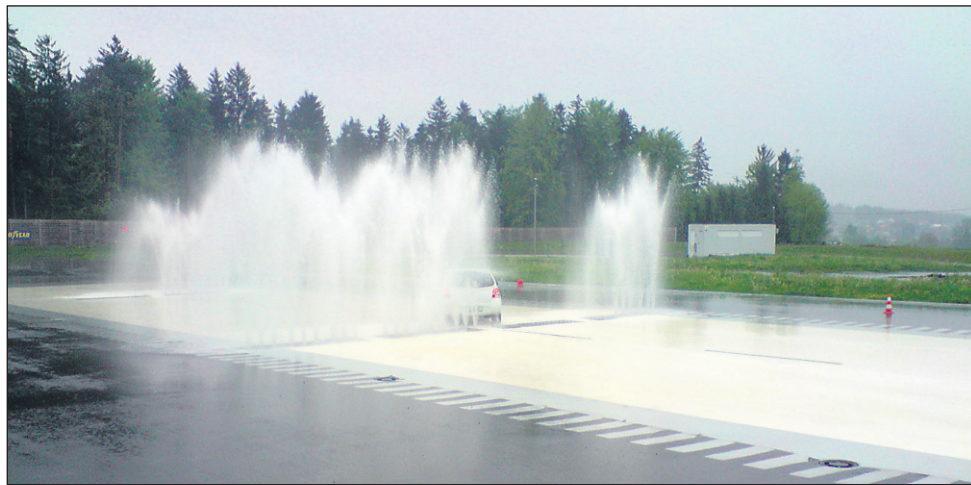
Foto: D. Majcen Del cestišča je prekrit s posebno podlago, ki ima v dežju podoben oprijem kot sprijet sneg.
