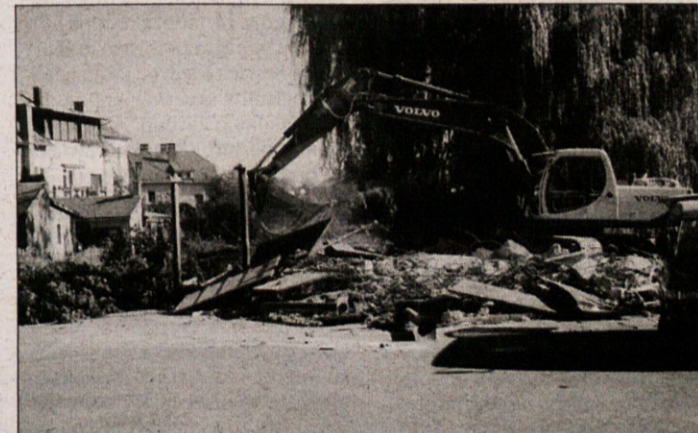
NAPREDEK - Pritlična zidana stavba na parkirnem prostoru ob stavbi Ljubljanske banke v Kočevju je bila zgrajena še v času, ko je na mestu banke še stalo staro leseno poslopje nekdanje avtobusne postaje. Stavbo so zgradili kot pralnico za potrebe AMD Kočevje in v njej so nekaj časa prali tudi avtobuse. Čeprav je onesnažena voda od pranja avtobobilov odtokala direktno v bližnjo Rinžo, zaradi česar je morala pralnica prenehati obratovati, pa je bilo to še vedno boljše kot sedaj, ko vozniki avtobuse perejo kar na parkirnem prostoru, od koder pa se tako kot prej tudi sedaj umazana voda steka v Rinžo! Stavbo, ki je bila zadnja štiri leta prazna, so v imenu napredka v teh dneh porušili. Na njenem mestu bo zrasla moderna poslovno-trgovska stavba, v kateri bo še pred koncem letošnjega leta odprla svoja vrata Tkanina, d.d., iz Celja. (Foto: M. L.-S.)
