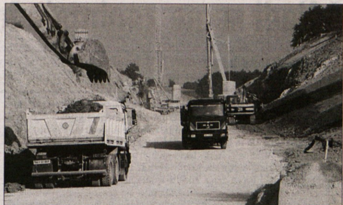
DELO NA TRASI - Na trasi novomeške severne obvoznice je zadnji mesec in pol delo v polnem zamahu. Če bo vreme dopuščalo, bodo delali do sredine novembra in opravili 70 odst. vseh del. (Foto: A. B.)
