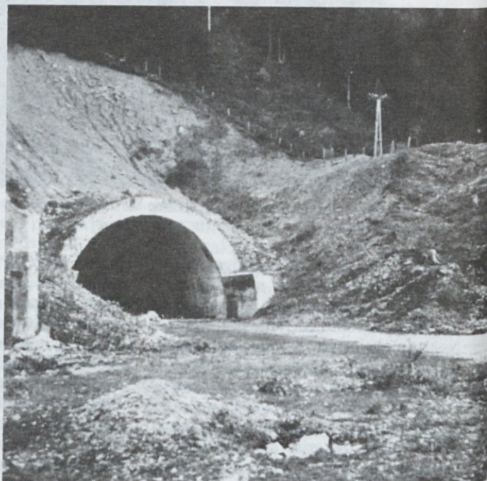
Še ne dokončani predor na Ljubelju.
