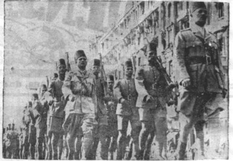
EGIPTSKA PEHOTA v mimohodu na ulicah Kaira
