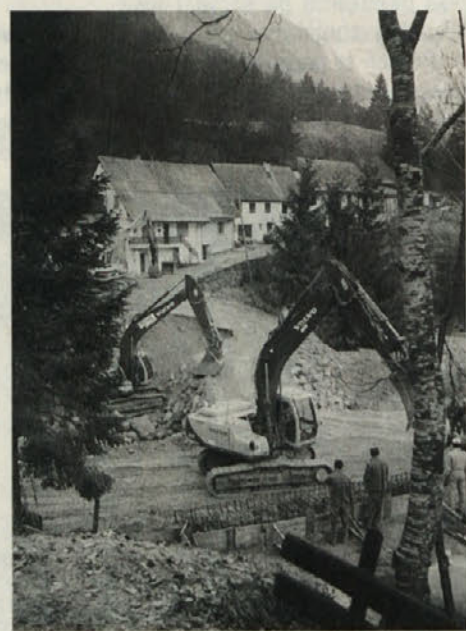
Delo pri nasipu za provizorično cest in 35 metrov dolg most
