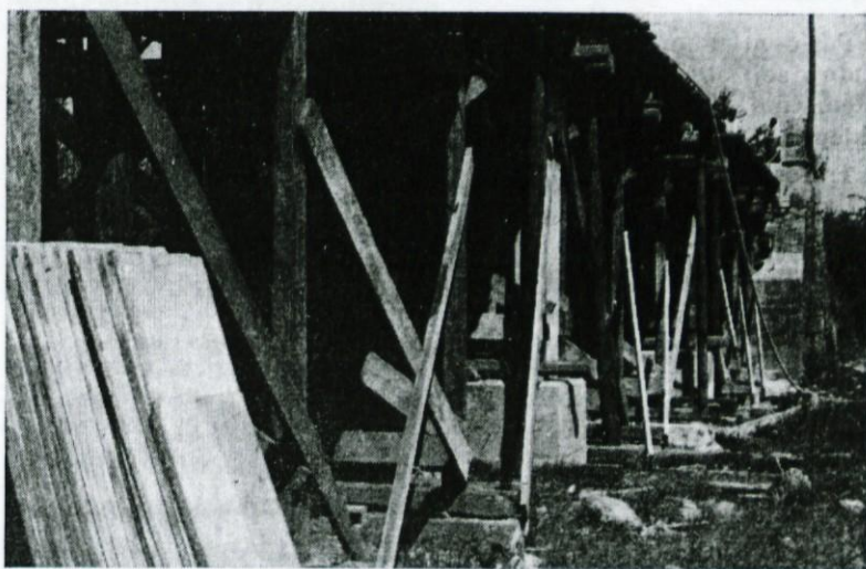
Novi betonski most bo spet povezoval Laze s Planino
