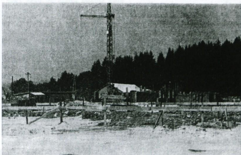
Veliko gradbišče električne razdelilne postaje za Notranjsko
