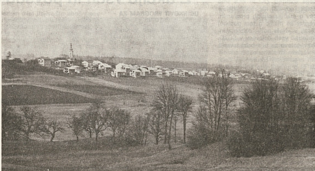
Urbanistična rešitev Lenarta v Slov. goricah zagotavlja temu kraju speljavo ulic z vodovodom in kanalizacijo oziroma cest med vrstami novih stanovanjskih hiš vzhodno in zapadno od poslovnega centra Lenarta. Zlasti na vzhodno stran je še dovolj prostora za širitev stanovanjskega dela Lenarta
