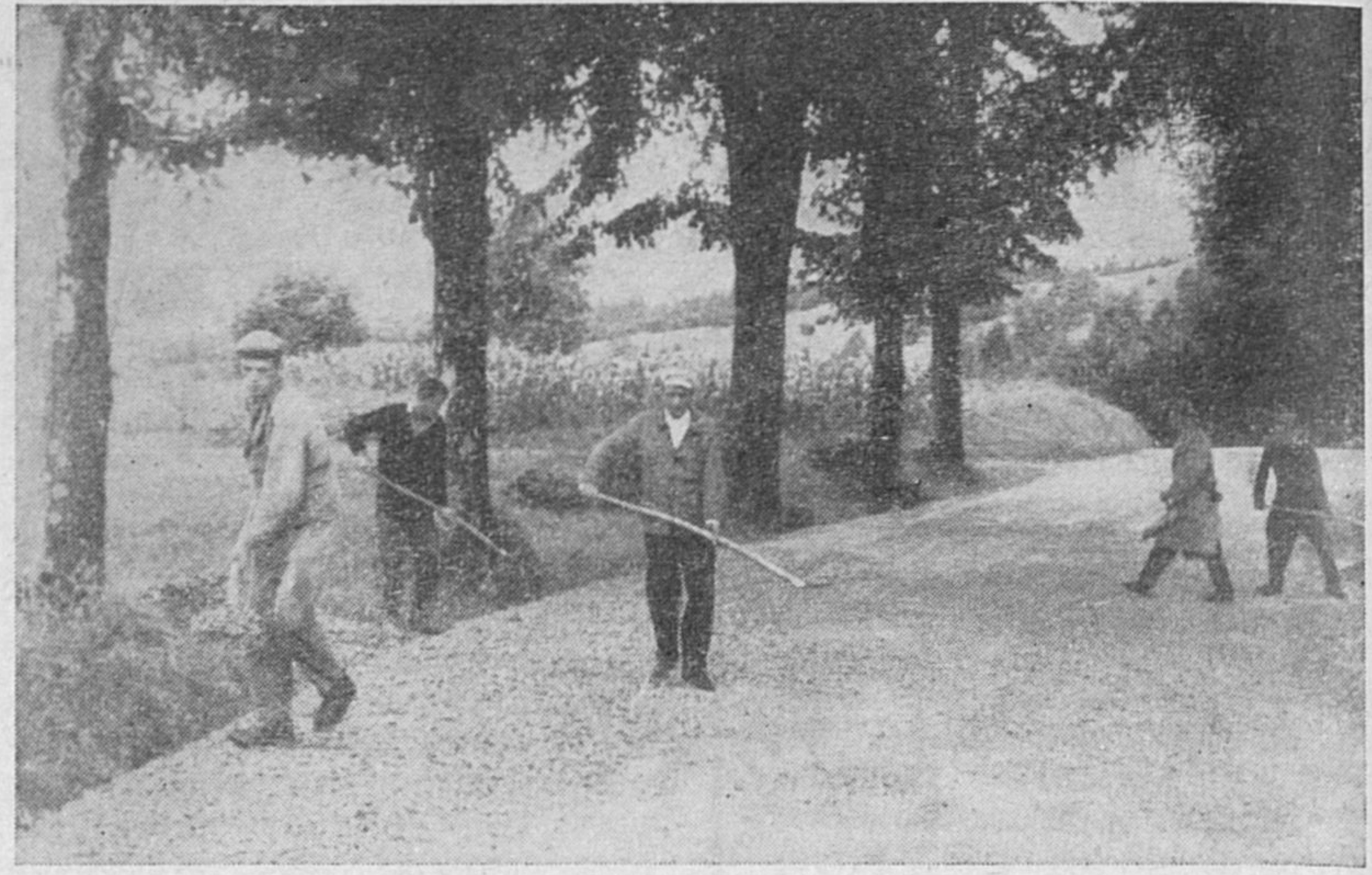
Delavci Cestnega podjetja iz Ljubljane so že začeli asfaltirati cesto od Unca proti Planini. Kot so nam povedali jo bodo asfaltirali le do občinske meje s Postojno, naprej pa bo cesto do glavne ceste v Planini asfaltiralo Cestno podjetje iz Kopra
