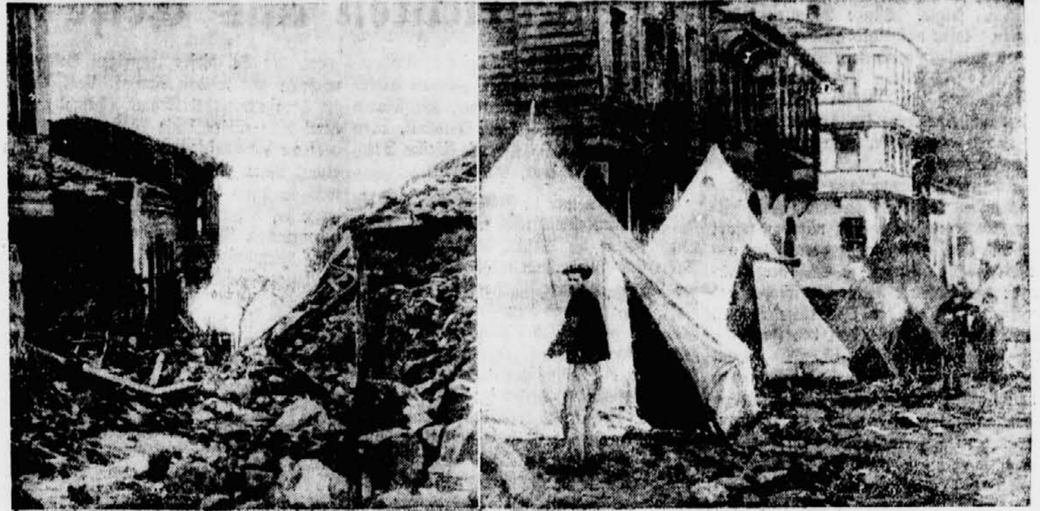
In der türkischen Küste erfolgte vor wenigen Tagen ein jäheres Erdbeben, durch das zahlreiche Dörfer und kleinere Städte zerstört wurden. Unser Bild zeigt eine in Ruinen verwandelte Straße in Marmara. Rechts sieht man die Zelte, in denen die aufgeschreckte Bevölkerung nach der Zerstörung ihrer Häuser kampierte.
