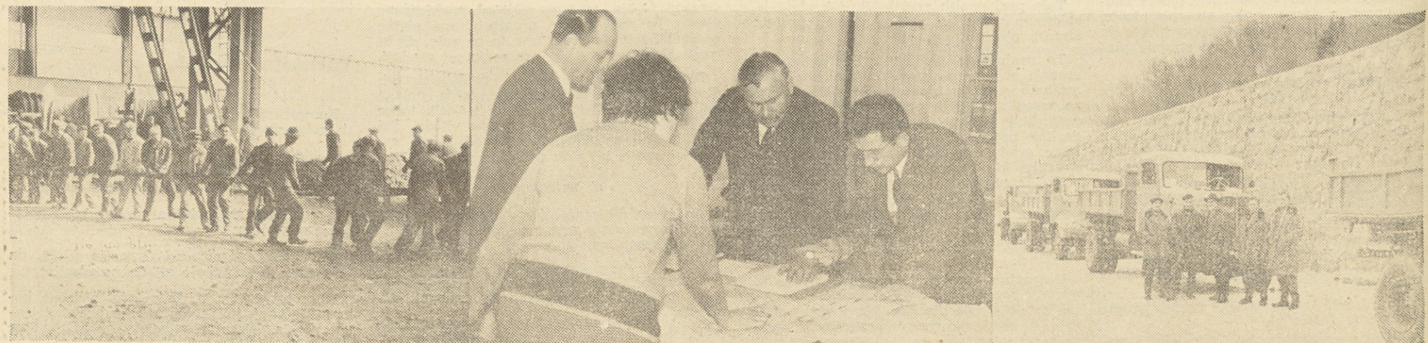
Levo: Veliko močnih rok je bilo potrebno, da so odvihli in položili kabel za visoko napetost k 40-tonski indukcijski peči v novi livarni ravenske železarne — Sredi: Strokovna razprava v poslovni enoti Celje (inž. Ferdo Cviki, Ludvik Šnajder, inž. Mitja Kiler in inž. Nada Del Fabro. Od dobre priprave gradbišča je namreč odvisen celoten uspeh — Desno: Prevzem novih avtomobilov za naše podjetje v Priboju v Srbiji. Skupina naših starih asov šoferjev, ki je prevzela nove avtomobile, se radostno smehlja
