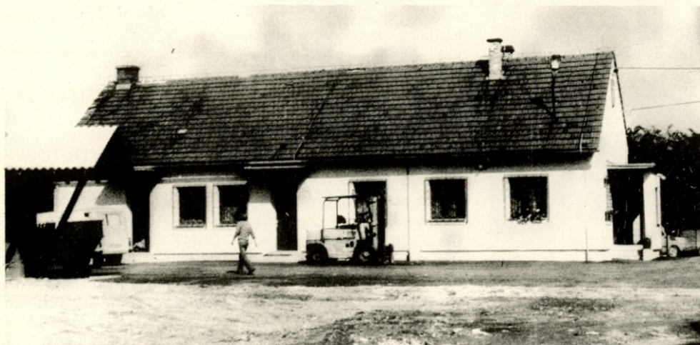
Obnovljena garderobno-upravna stavba našega skladišča v Murški Soboti
