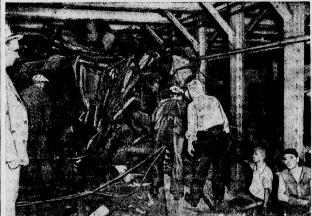
Von dem schweren U-Bahnglück in Newyork trafen jetzt die ersten Bilder ein. In der Nähe der Lexington-Avenue stießen zwei Untergrundbahnzüge zusammen. Das Unglück forderte mehrere Tote und über 50 Verletzte. Unser Bild zeigt einen Teil der Trümmerstätte im U-Bahnschacht
