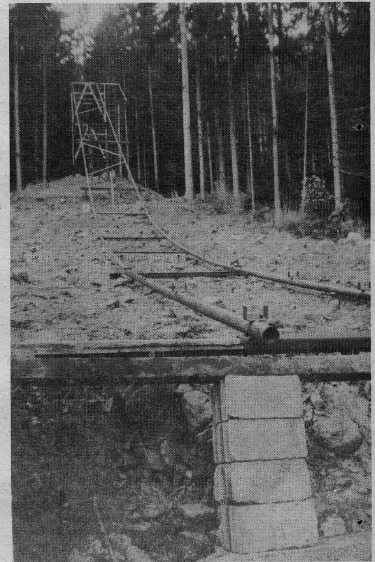
Ljubenski smučarski skakalci se že z vsjo paro pripravljajo na smučarsko sezono. Veliki uspehi njihovih tekmovalcev v lanskem sezoni, so dobra vzpodbuda za delo vnaprej. V teh dneh končujejo tudi obnovo 35-metrsk skakalnice, ki bo dobila novo zaletišče, prevlečena pa bo z umetno snovjo. Vsa dela opravljajo sami, v veliko pomoč pa so jim delovne organizacije iz naše občine.
