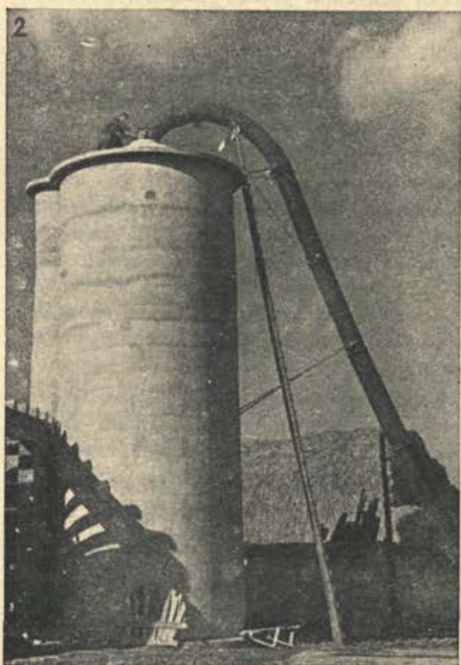
Dvojni silos za shranjevanje kisle krme v Jabljah pri Mengšu.
