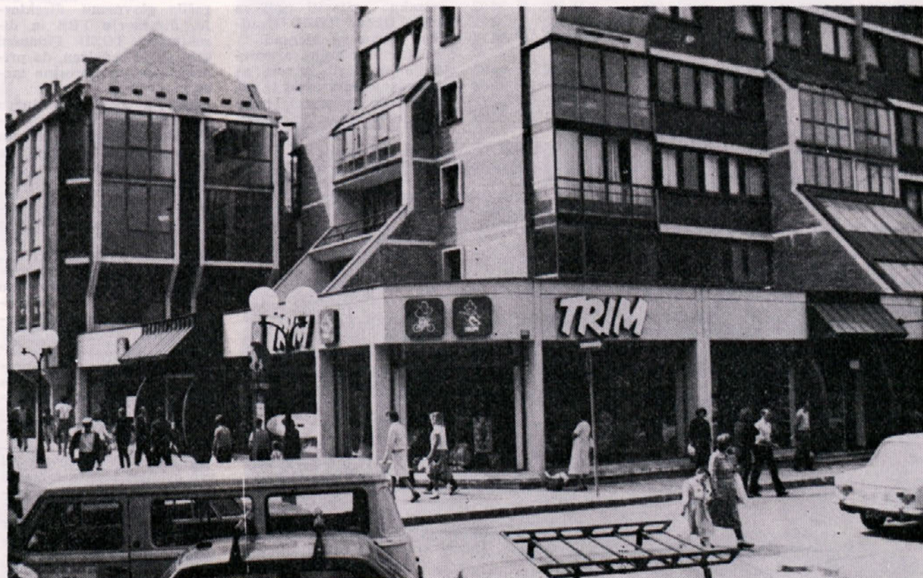
Poslovno-stanovanjska stolpnica v Miklošičevi ulici in poslovni objekt v Stanetovi ulici sta smoterno zapolnila dragocen prostor v središču Celja. Izvajalec del TOZD GO Celje.
