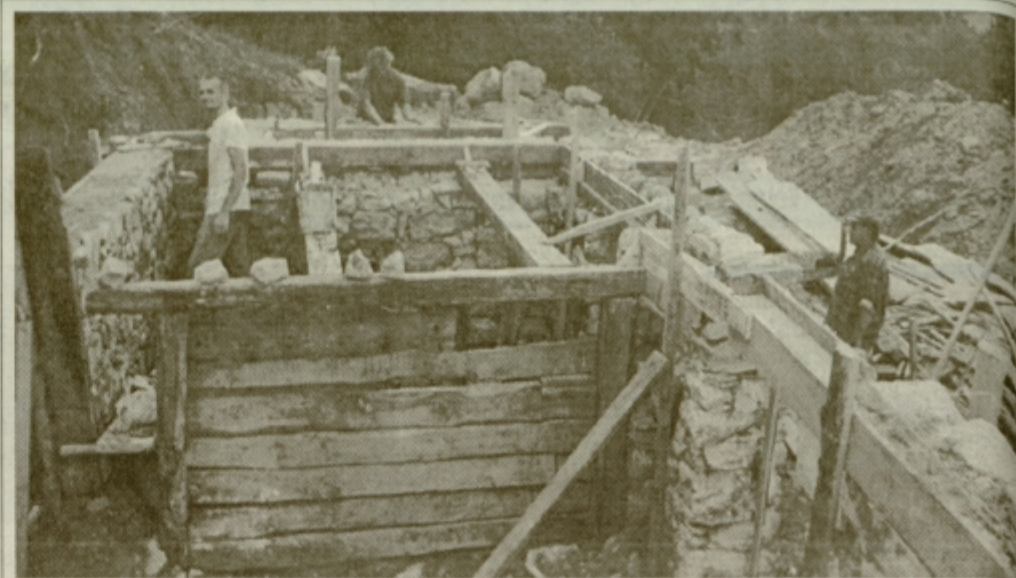
V razpadajoči hiši v Ravnem so morali začasno odstraniti lesena bruna ter najprej utrditi kamnite kletne zidove.
