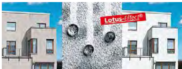
Slika 11. Fasada brez lotusana (levo) in z lotusanom (desno) [vir: MNN HOLDING COMPANY, 2014].
