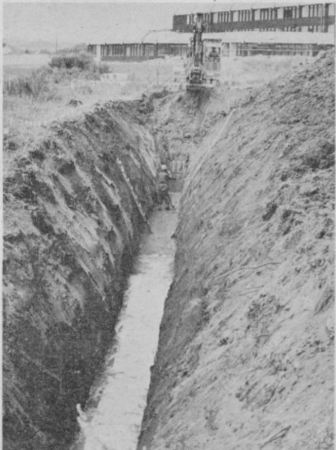
Stroj, ki opravi dnevno delo za sto parov krepkih rok se z izkopom kanalizacijskega jarka vse bolj približuje zgradbi srednjoveškega centra
