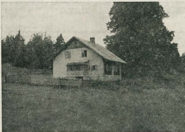
Drvarska kočja OBRETAN — Foto: A. Mravljak
