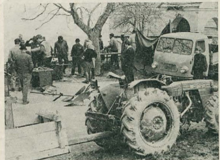
Na delovišču kjer so delavci remontne skupine hidrocentrale Vuhred popravljali orodje brezplačno je bil pravcati živžav. Foto: F. Jurač
