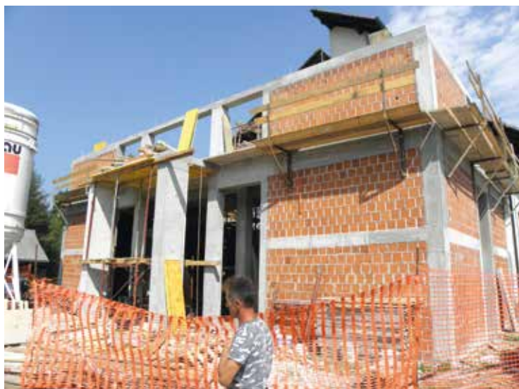
Gradnja prizidka h gasilskemu domu na Igu
