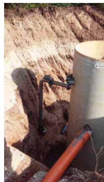
Gradnja črpališča v Tomišlju
