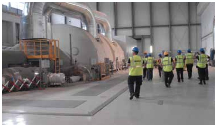
Ogled Termoelektrarne Šoštanj
