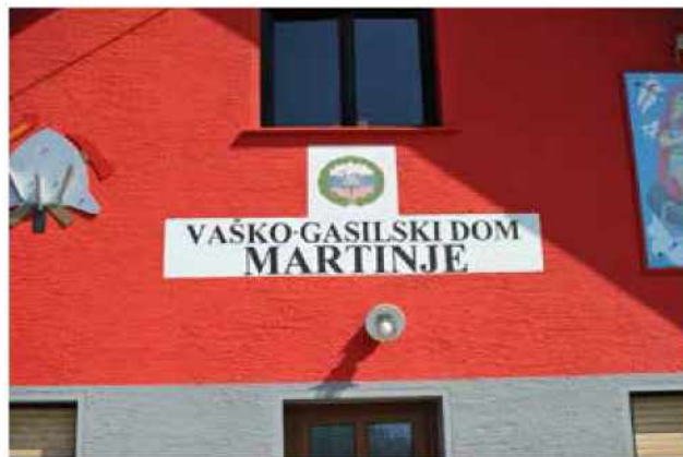
Prenovljeni vaško - gasilski dom v Martinju
