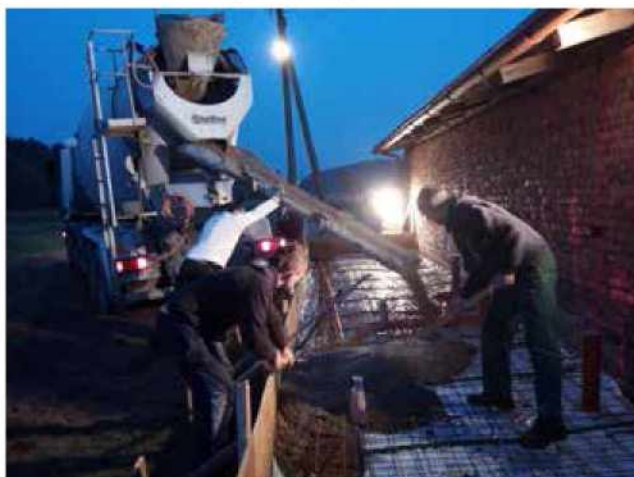
Gradnja novih sanitarij pri klubski hiši
