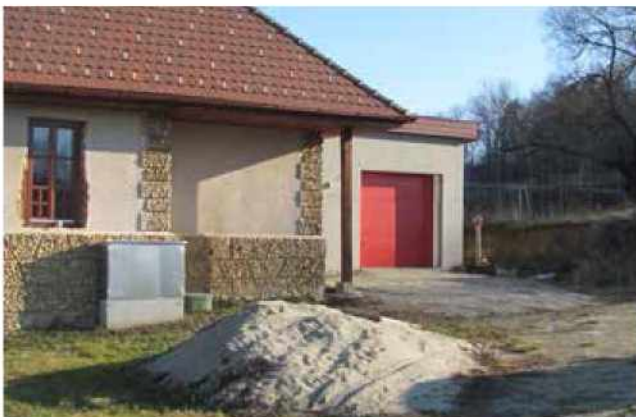
Vaško - gasilski dom v Adrijancih - v gradnji
