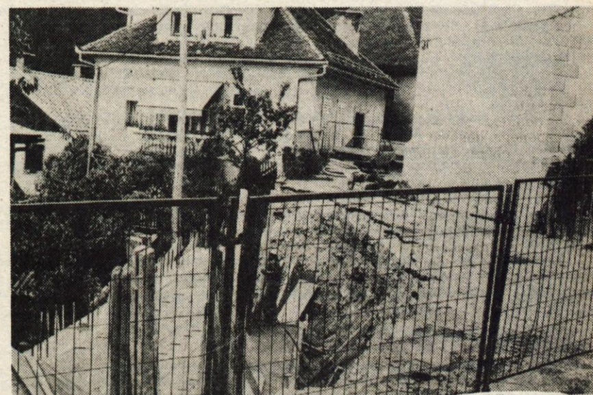
Ozka cesta okrog tržiške cerkve in pokopališča je vsa razpokana že dalj časa, grozilo, da bo nekega dne zdrknila po bregu. Preden bi se zgodilo kaj hujšega, so jo cestni delavci zaprli, spodkopali in temelje znova utrdili. To nedeljo so cesto spet odprli, čeprav nov asfalt še ni položen. Stanovanci okrog cerkve in Damulneka so si odahnili, saj so si morali ves mesec dni utirati pot kar čez pokopališče. — Foto: D. Dolenc
