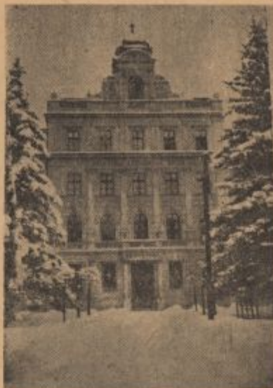
Pročelje škofovih zavodov.
