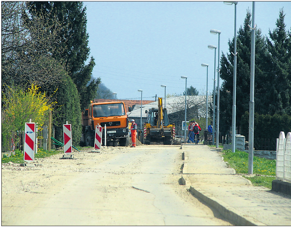
Izgradnja kanalizacije v Mezgovcih bo končana letos poleti; cena kanalsčine pa bo znašala 1,25 evra za porabljen kubični meter vode.
