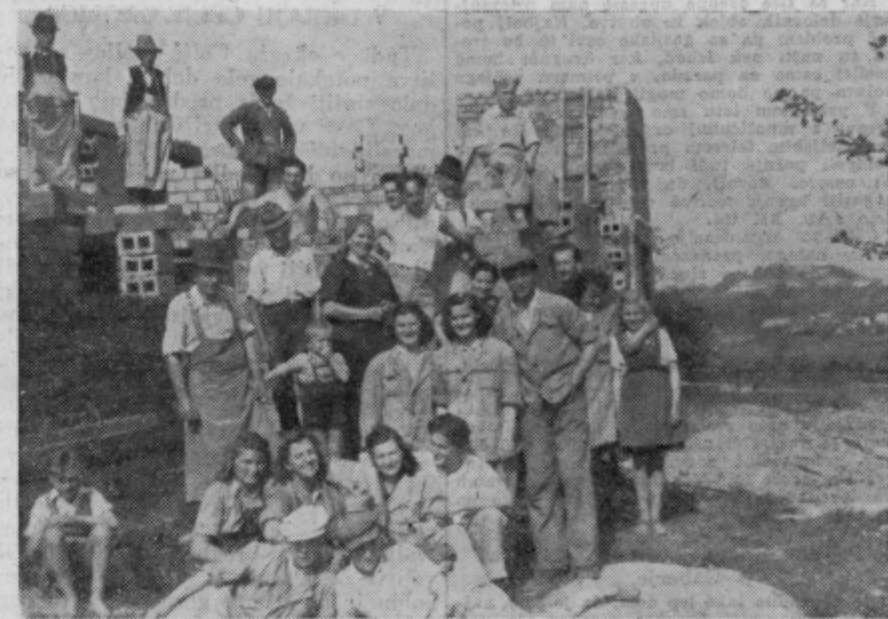
Gasilci in vaščani Lokrovecu grade gasilski dom
