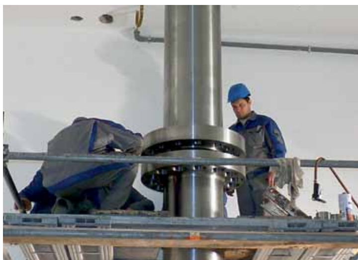
Montaža rotorja turbine.
