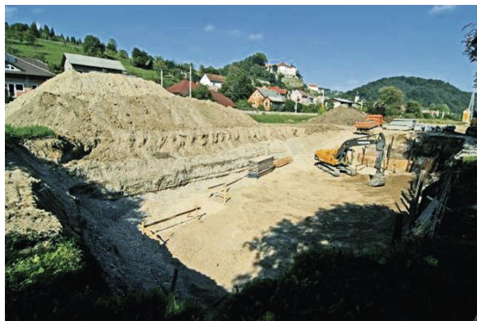
Slika 7 • Gradnja visokovodnih nasipov ob Savi (foto: Ljubo Motore)
