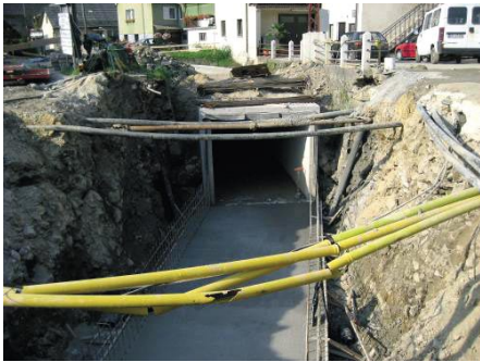
Slika 17 • Utesnjena gradnja ob Drožanjskem potoku (foto: Uroš Krajnc)
