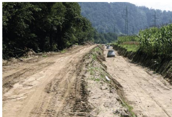
Slika 9 • Gradnja kanalizacije (foto: Ljubo Motore)
