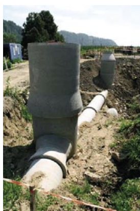
Slika 10 • Gradnja kanalizacije (foto: Ljubo Motore)
