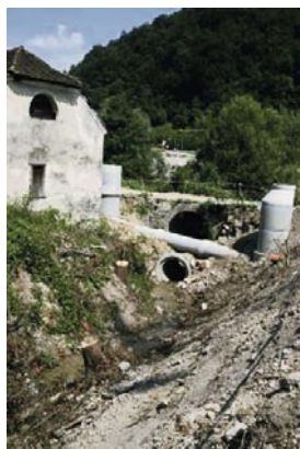
Slika 8 • Gradnja kanalizacije (foto: Ljubo Motore)
