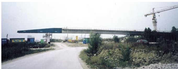
Slika 3 • Narivanje prekladne konstrukcije na viaduktu Bonifika dolžine 547 m
