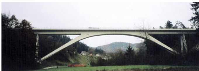
Slika 9 • Viadukt na radeljski obvoznici
