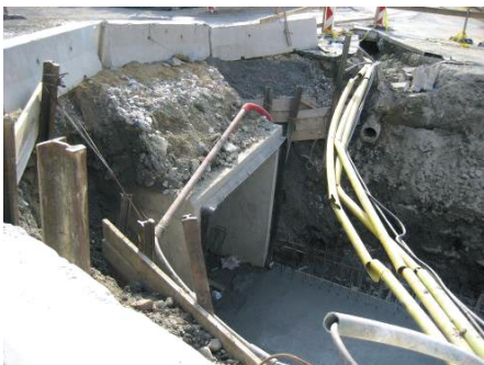
Slika 18 • Utesnjena gradnja ob Drožanjskem potoku (foto: Uroš Krajnc)
