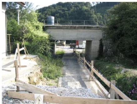
Slika 20 • Utesnjena gradnja ob Florjanskim potoku (foto: Uroš Krajnc)
