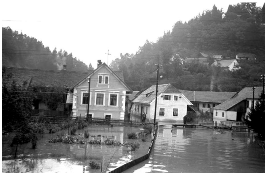
Slika 3 • Poplave Drožanjskega potoka v Sevnici leta 1932 (foto: dr. Drago Mušič)
