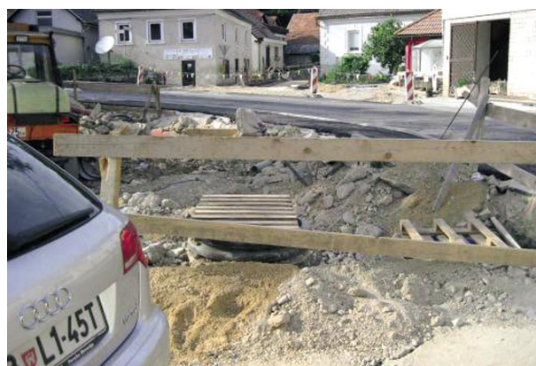
Slika 11 • Kanaliziranje Florjanskega potoka (foto: Uroš Krajnc)
