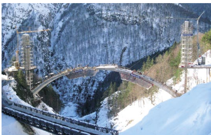
Slika 10 • Viadukt Mangart v gradnji
