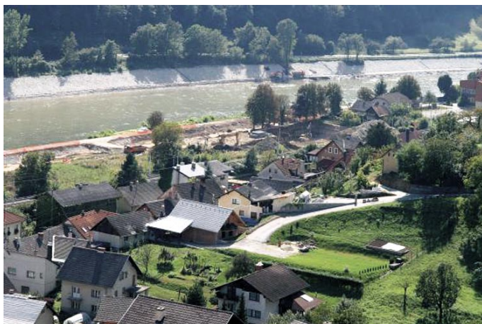
Slika 6 • Visokovodni nasipi ob Savi (foto: Ljubo Motore)
