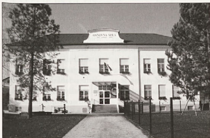
Podružnična šola v Leskovcu je obnovljena, ima pa tudi telovadnico in oddelek vrtca.
