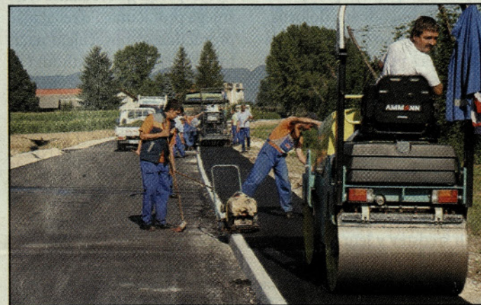
Pri asfaltiranju 720 m dolgega pločnika ob cesti proti Vrbju
