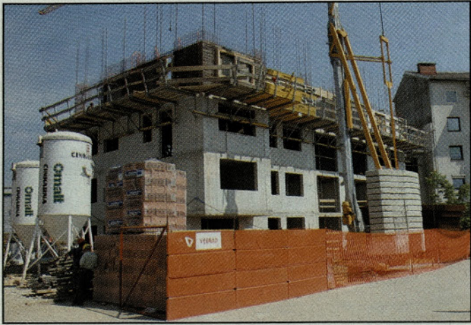
Gradnja 23-stanovanjskega bloka
