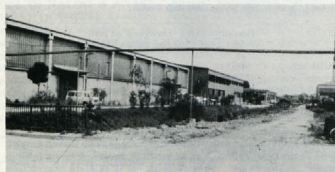
Pogled na nove investicije. Na levem bregu potoka stojijo stari in novi Veflon ter hala Vzdrževanja
