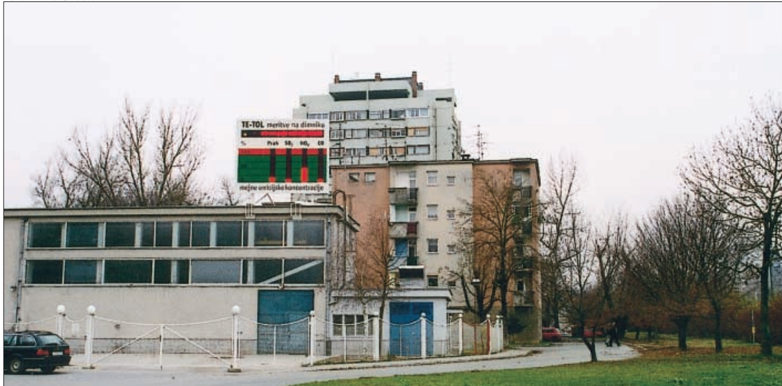
Prikazovalnik emisij na črpališču vode ob Zaloški cesti.
