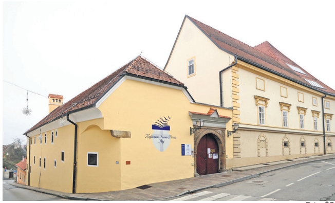
En del knjižnične stavbe že ima novo fasado.
