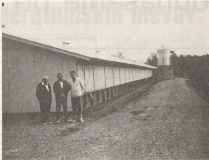
Tipični zunanji izgled objekta na ameriški farmi (namesto zidane stene je močno platno) (Foto: Franc Kac)
