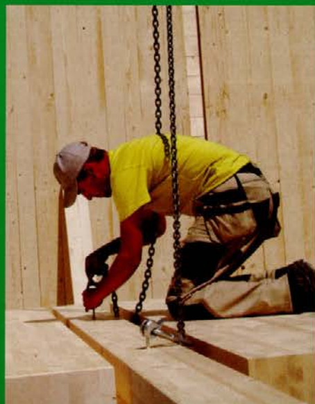
Med gradnjo poslovnega objekta v Radljah
