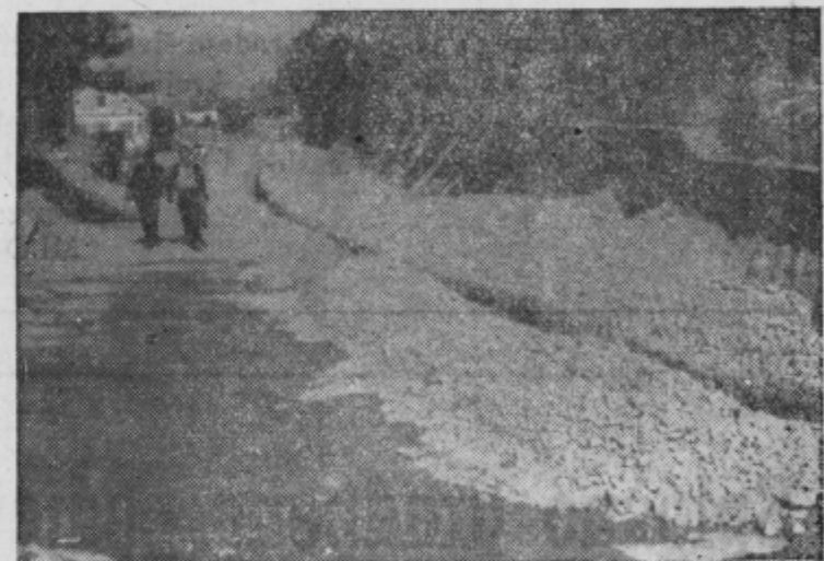
Teharska cesta med gradnjo
