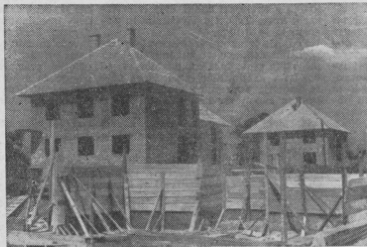
Stanovanjske zgradbe med gradnjo (za I. gimnazijo). Fotolik
