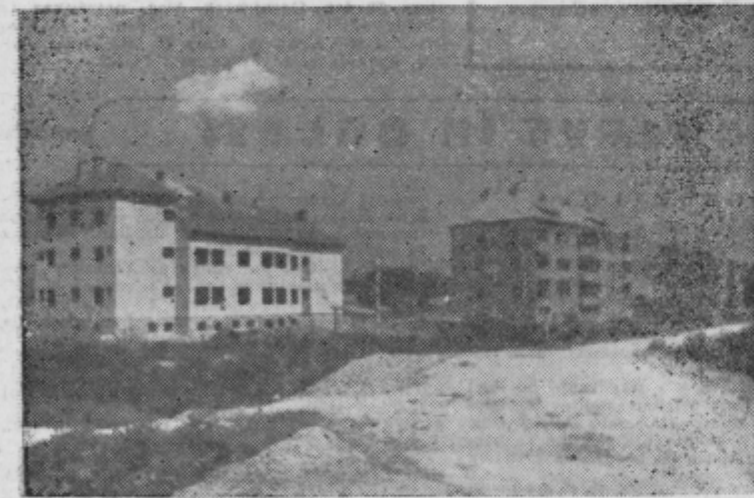
Gradnja stanovanjskih blokov ob Dečkovi cesti
