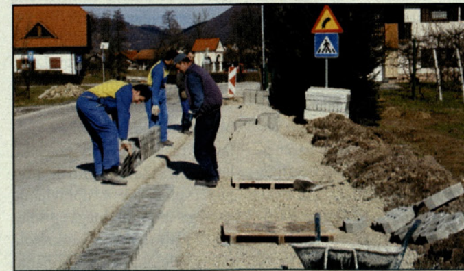
Med gradnjo steze proti Braslovčam.
