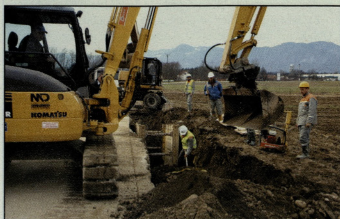
Začetek gradnje kanalizacije
