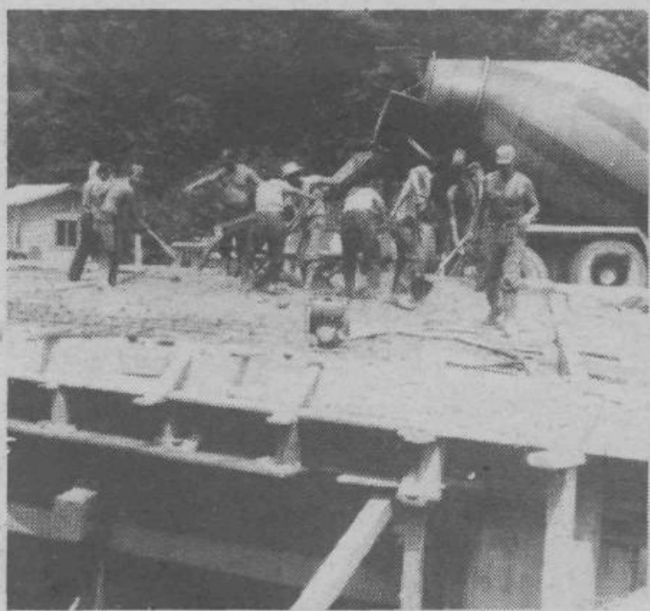
Gradnja mostu v Besnici (Foto C. Zupancič)
