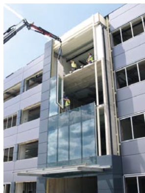
Slika 7 • a) Detajl pritrditve b) Montaža elementa Qbiss Air na gradbišču (Trimo, 2012)
