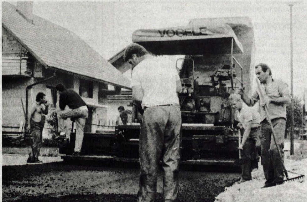
ULICE NOVIH ŠENČURSKIH NASELJ ASFALTIRANE - Dolgotrajno dogovarjanje za končno komunalno ureditev novih naselij v krajevni skupnosti Šenčur je skrajšala hitra izvedba del. Delavci kranjskega cestnega podjetja so od konca aprila do začetka junija položili asfalt na vseh ulicah v Sajovčevem in Mačkovem naselju ter ob delu Pipanove ceste. Čaka jih le še ureditev cestnih robov. ● S. S. - Foto: S. Saje
