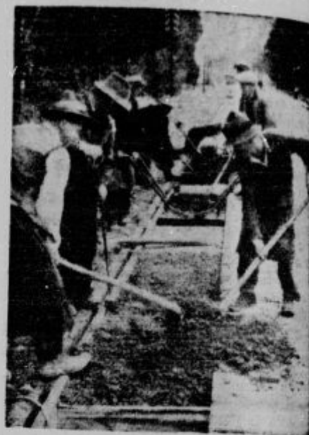
Betoniranje obrobnega, 75 cm širokega betonskega pasu iz črno pobarvane betonske mešanice.
