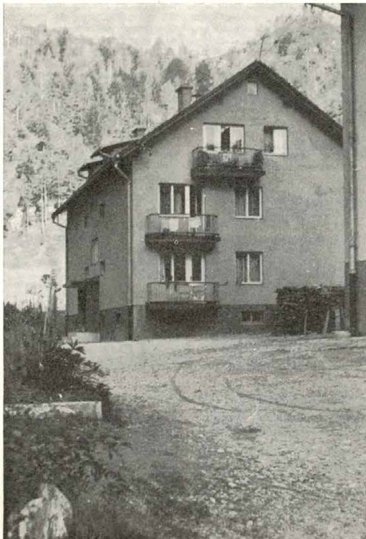
Stanovanjsko poslopje za devet družin — zgrajeno 1964. leta v Rudarjevem — Črna na Koroškem. (Foto: A. Šertel)
