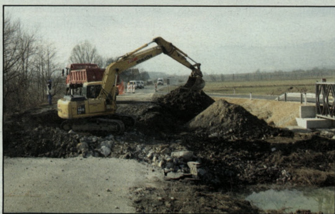
Gradnja novega mostu
