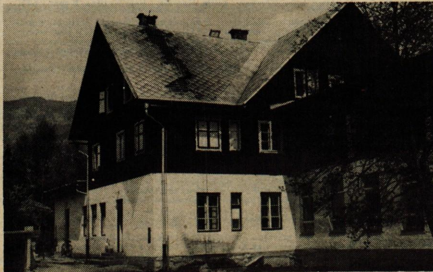
Hotel Jezero v Bohinju so že v soboto zaprli. Poleg podrtega dimnika in poškodovane strehe so se pojavile precejšnje razpoke tudi v sobah v starem delu hotela.
