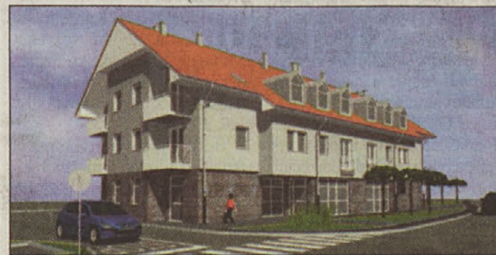
Takšen bo objekt, ko bo dograjen.
