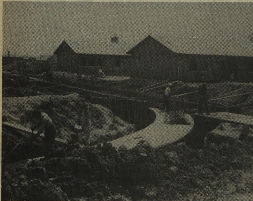
Najprej so morali z gradbišča spraviti podtalno vodo
