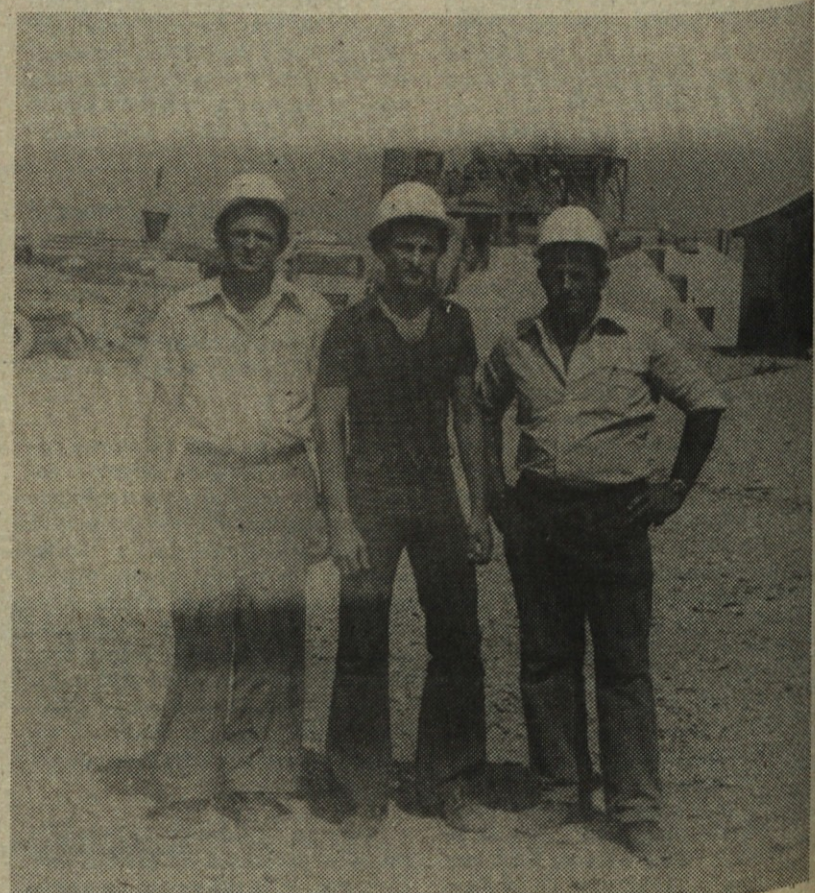
Gradnja mostu čez Moračo se je pričela
