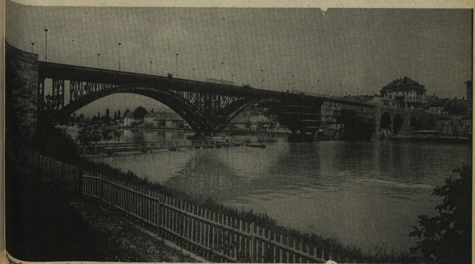
opravilo starega mariborskega mostu
