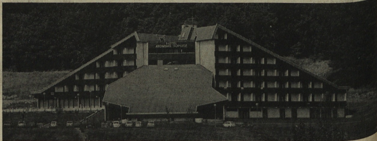
Nedavno odprt hotel »Atomske toplice« v Podčetrtku, katerega so izvajali delavci naše TOZD GE Celje
