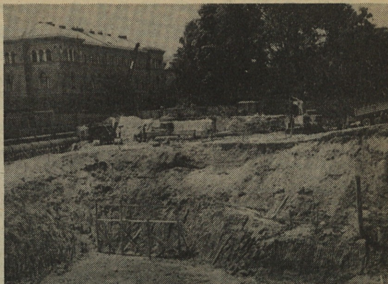
Izkop za kulturni center je precej zahtevno delo
