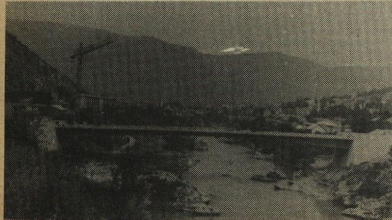
Novi most v Mostarju je v zaključni fazi
