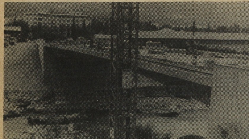
Zaključna dela na mostu v Mostarju opravljajo delavci Nizkih gradenj
