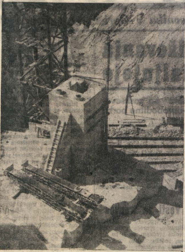
OGROMNO DELO PRI HIDROCENTRALI GRE H KONCI. NA SLIKI VIDIMO DEL OBJEKTA MED GRADNJO
