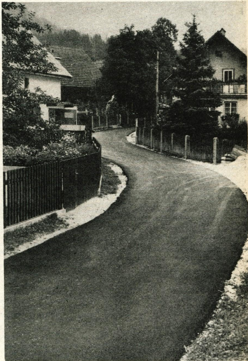
V Mojstrani so že prvo leto asfaltirali več kot polovico krajevnih cest. — Foto: F. Perdan
