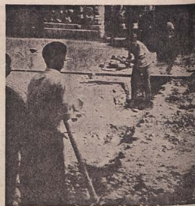
Predzadnji prekop ceste v Kočevju zaradi 10 kilovoltne kableske zanke je bil opravljen na Trgu svobode. Zadnjič pa bodo zaradi krožnega napajanja Kočevja z elektriko prekopali cesto pri Roškem mostu. (Foto: Prime)
