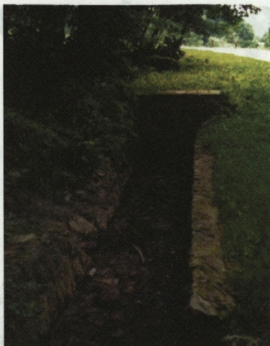
Slika 5: Vtok potoka v kanalizacijo v Tivoliju v Ljubljani
