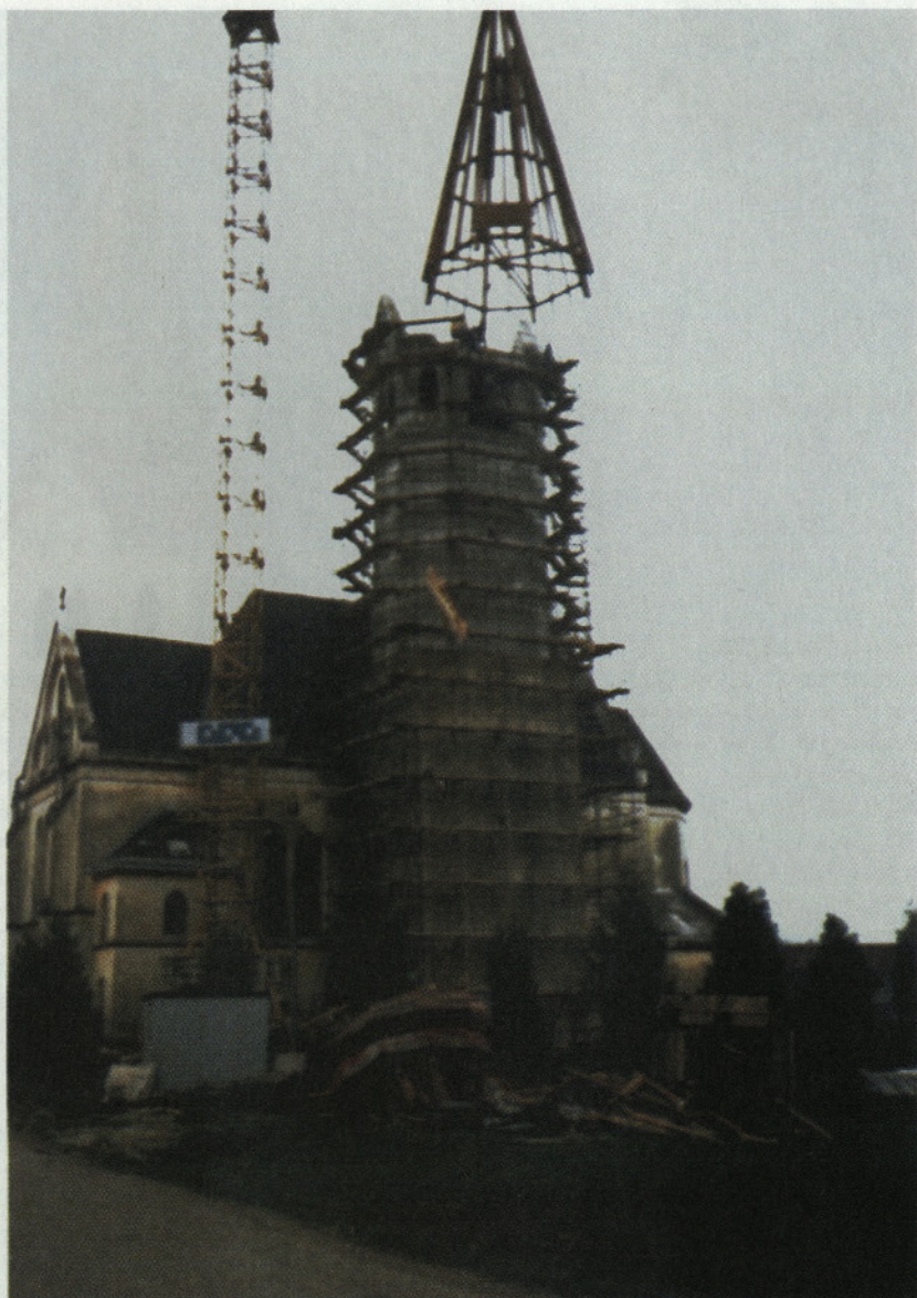
Slika 8: Dviganje nosilne konstrukcije strehe
